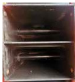
Powierzchnie wymiennika czyścić szczotką lub odkurzaczem.
