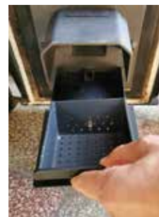
Czyszczenie tygla palnika XPell
